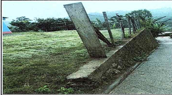
Foto 1: Reparación de muro perimetral.
