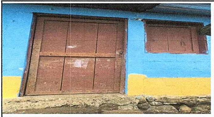
Foto 4: Sustitucion de Puertas y ventanas de madera, por metal
